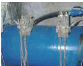
Para almacenar los datos del caudalímetro se empleaba una unidad TINY-TAG. Esta unidad registra una señal de 0 a 20 mA, proporcionada por el caudalímetro, que se transforma en un registro de caudal.
