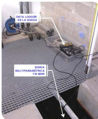
Instalación de bombeo de la EDAR (pozo de llegada) y del sistema de medición en continuo (pH, CE, T°C)
