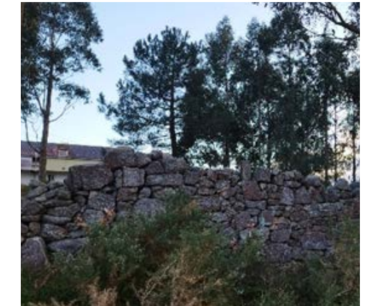
Fotografía dun valado de pedra seca no Monte da Fraga
