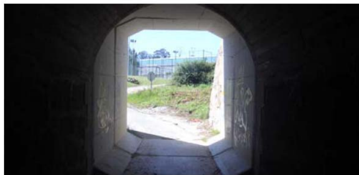
TUNEL BAIXO A VÍA DO TREN Á ENTRADA DO CAMPUS DE ELVIÑA
