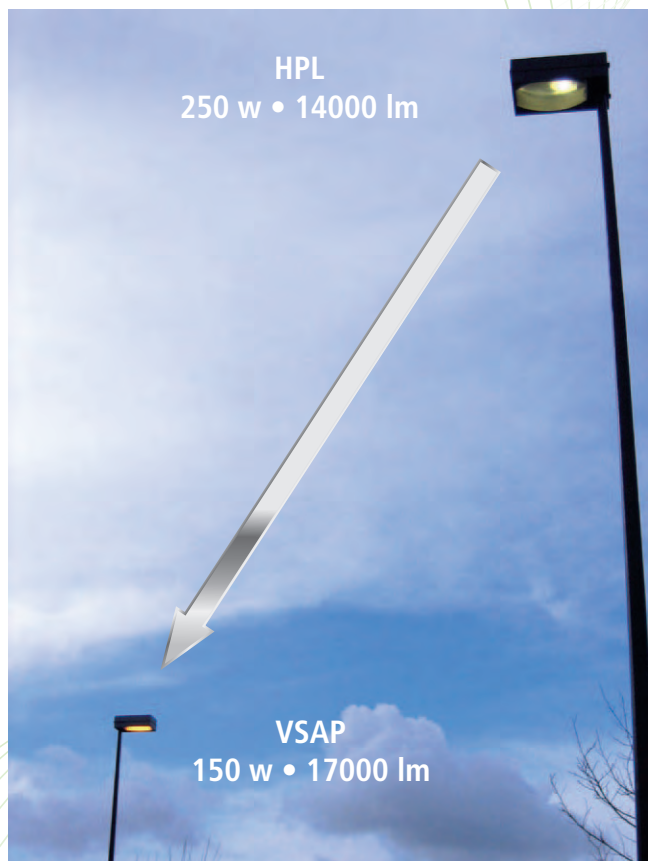
Cambio de lámpadas en iluminación exterior (Elviña, 2009)
