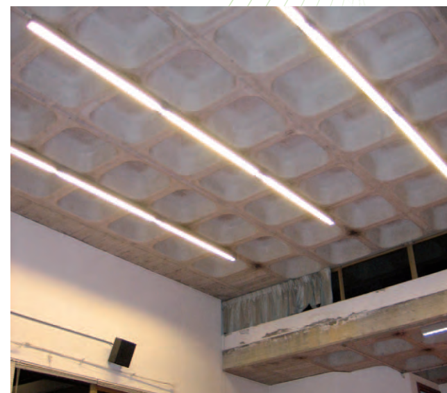
Mellora da eficiencia lumínica en dúas aulas especiais da Escola Universitaria de Arquitectura da UDC, 2007 (substitución de luminarias antigas –arriba– por outras de alta eficiencia –abaixo, e mellora da calidade da iluminación).
