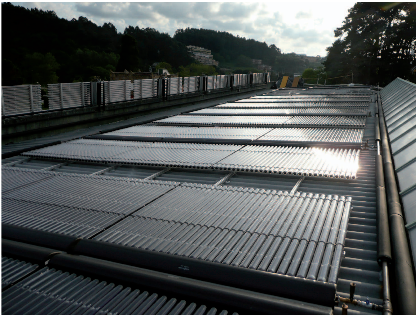
Instalación de enerxía solar térmica na Facultade de Ciencias do Deporte e da Educación Física (UDC). A tecnoloxía empregada é a de tubo de baleiro de fluxo directo (en total 140 m 2 ) con disposición en cuberta e en fachada (2008).
